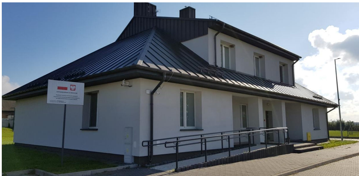
Rysunek 18 Wyremontowany budynek po dawnej szkole podstawowej w miejscowości Zalesie
