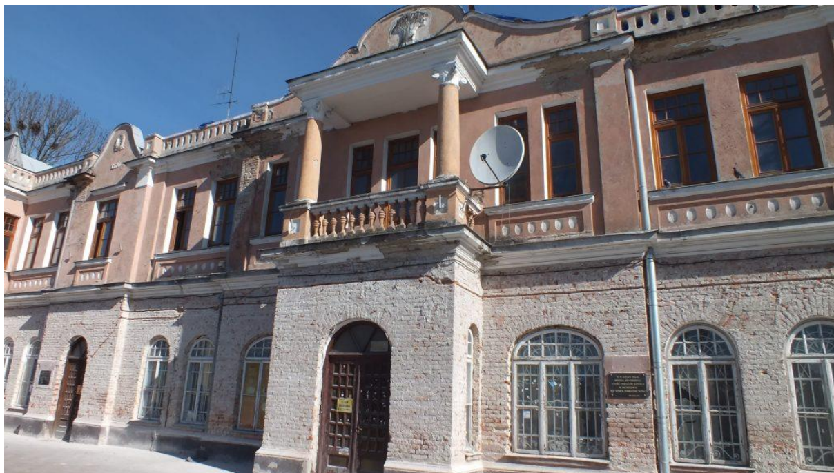
Rysunek 9 Budynek w trakcie prac remontowych
