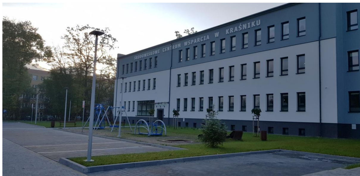
Rysunek 4 Budynek Środowiskowego Centrum Wsparcia w Kraśniku
