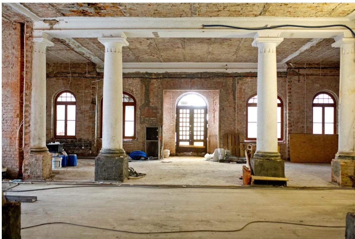
Rysunek 13 Budynek w trakcie prac remontowych
