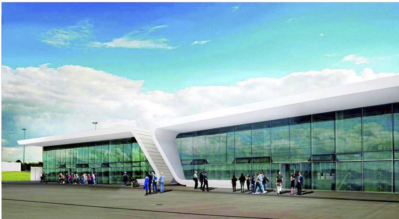
Terminal Portu Lotniczego Lublin czeka przebudowa. Zostanie on powiększony o nowy pawilon
