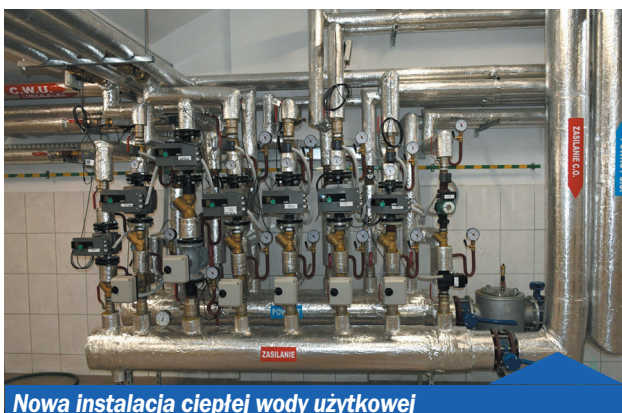
Nowa instalacja ciepłej wody użytkowej
