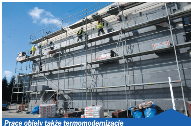
Prace objęły także termomodernizację
