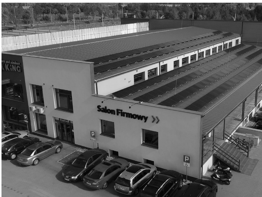
Przykład wykorzystania paneli słonecznych na dachu budynku.
