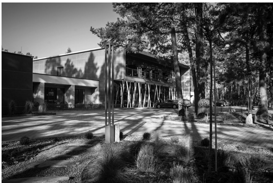
Termomodernizacja budynku hotelu Szumy Park
