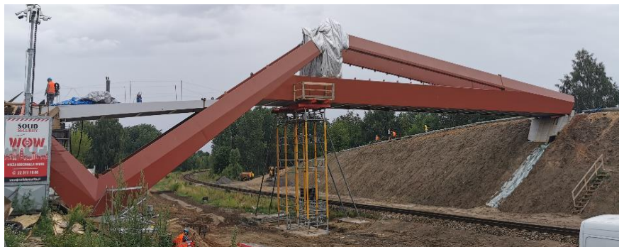
Rysunek 7. Budowa kładki w Lubartowie
