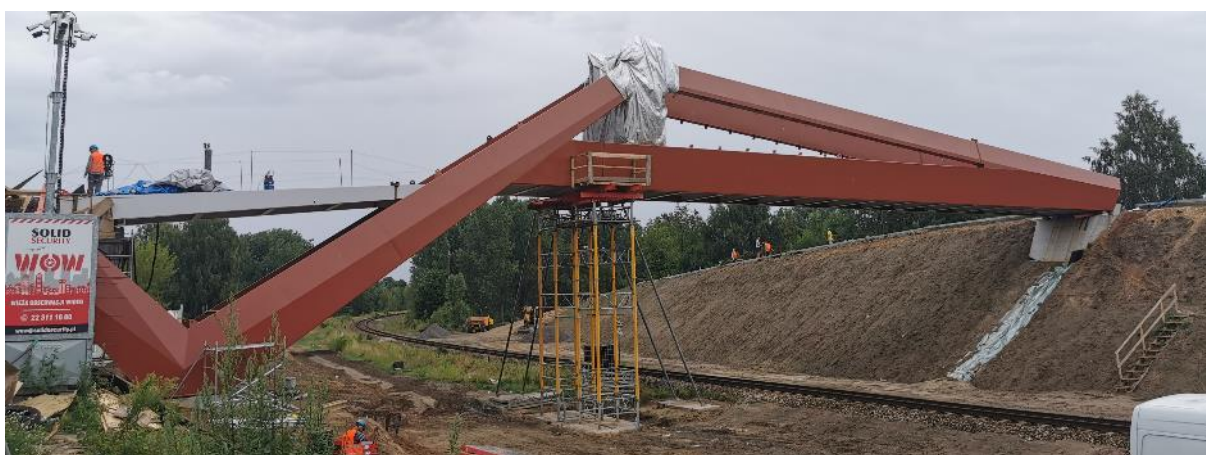
Rysunek 6. Budowa kładki w Lubartowie
