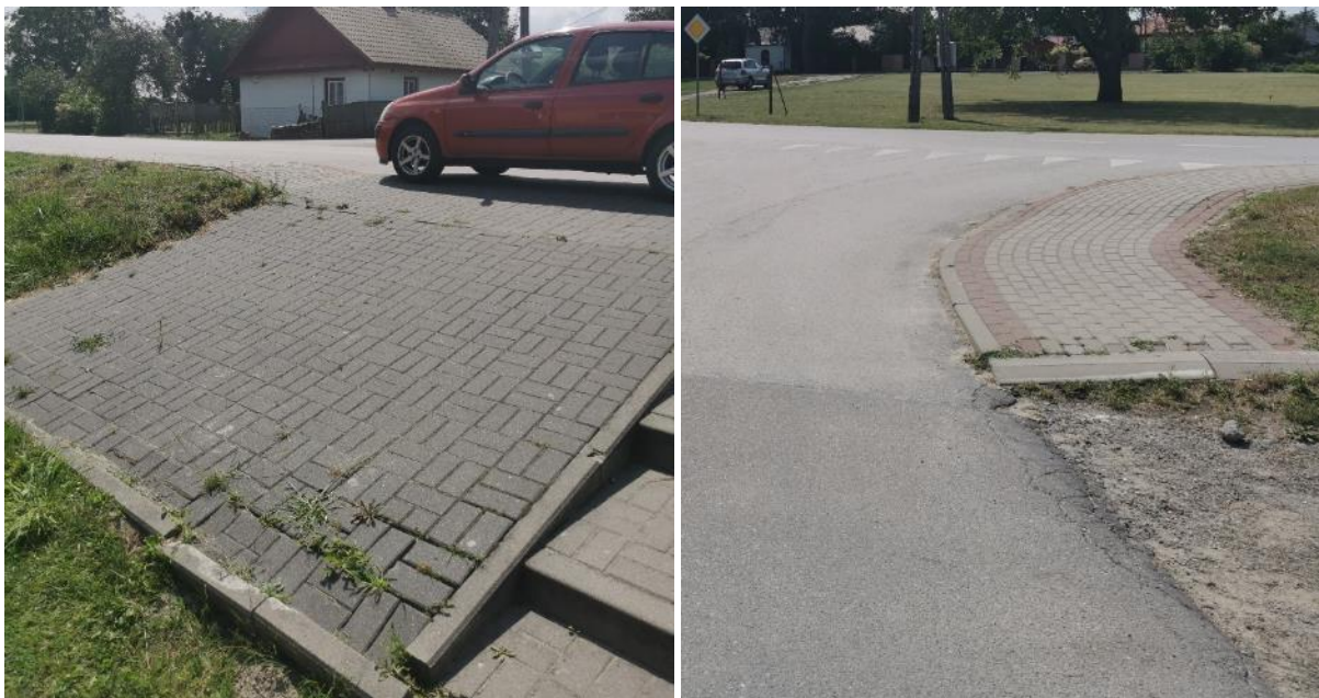
Rysunek 10. Zjazd dla osób z niepełnosprawnościami i chodnik przy drodze powiatowej w Brzeźnie
