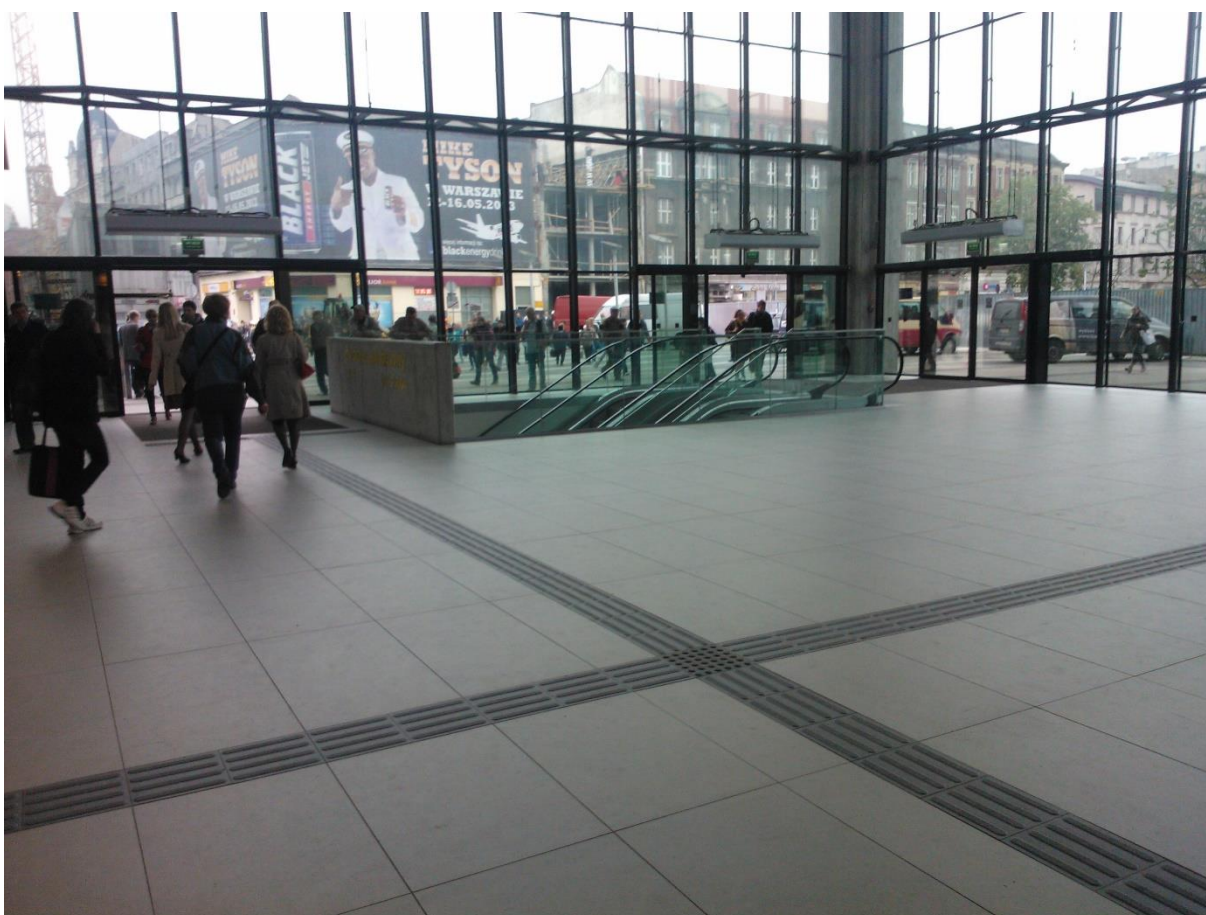
Fot. 57. Dworzec PKP Katowice: ścieżki dotykowe, fot. Kamil Kowalski.
