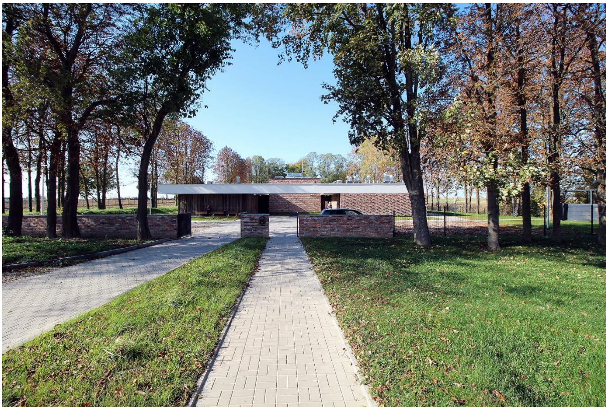
Fot. 6. Dom dla osób bezdomnych w Jankowicach: główne wejście na teren, fot. XYstudio.
