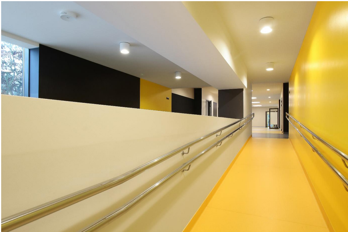
Fot. 13. Szkoła Podstawowa Nr 174 im. Tadeusza Kościuszki w Warszawie Wesolej: pochylnia w łączniku między budynkami, fot. XYstudio.
