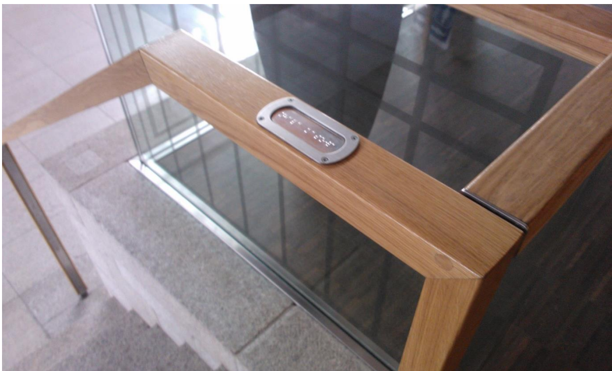
Fot. 56. Dworzec PKP Wrocław Główny: informacja dotykowa na poręczach schodów, fot. Kamil Kowalski.
